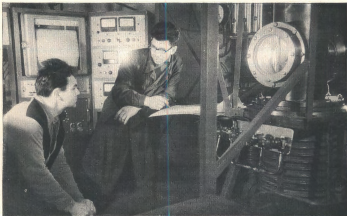
▲ Рис.4. В Лаборатории высоких энергий готовится эксперимент по изучению pp -взаимодействия в диапазоне энергий до 70 Гэв. Впервые в практике физического эксперимента взаимодействие частиц будет изучаться при помощи струи газообразного водорода, вводимой в камеру ускорителя. На снимке: отладка струйной мишени в криогенном отделе ЛВЭ. Научный сотрудник В.Никитин (слева) и аппаратчик А.Перов.
