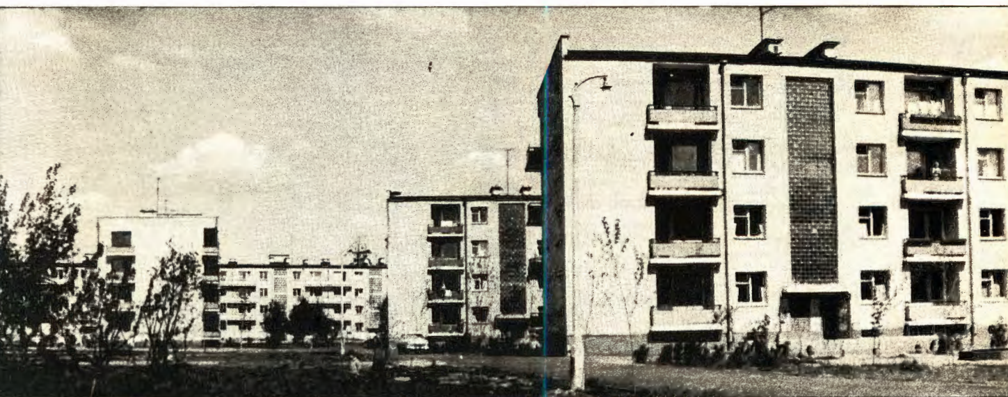
Рис. 142. На берегу Волги завершается строительство жилого массива по плану болгарских архитекторов. Уже сдано в эксплуатацию 20 тысяч квадратных метров жилой площади.
