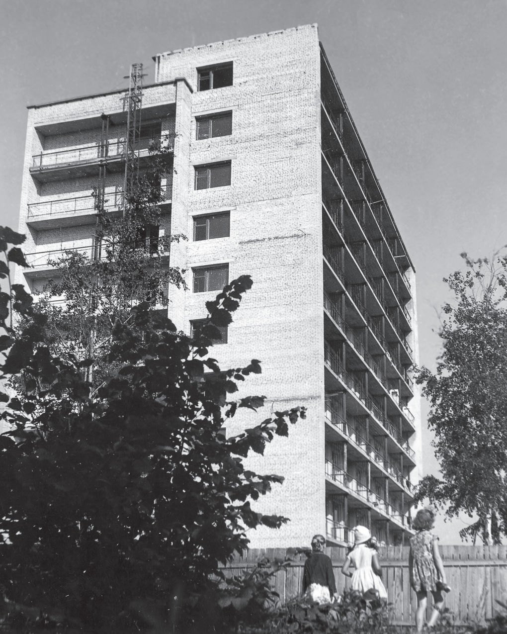
Конец 1960-х. Первый 10-этажный дом в Дубне, ул. Ленинградская, 1
