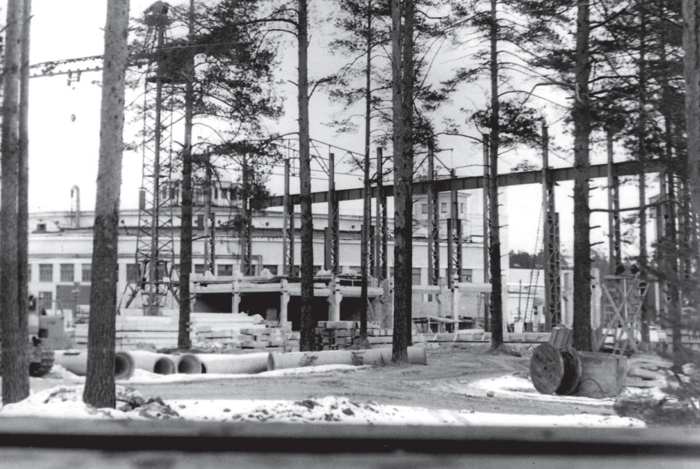
Лаборатория высоких энергий ОИЯИ. Строительство корпуса 205. 1974 г.
