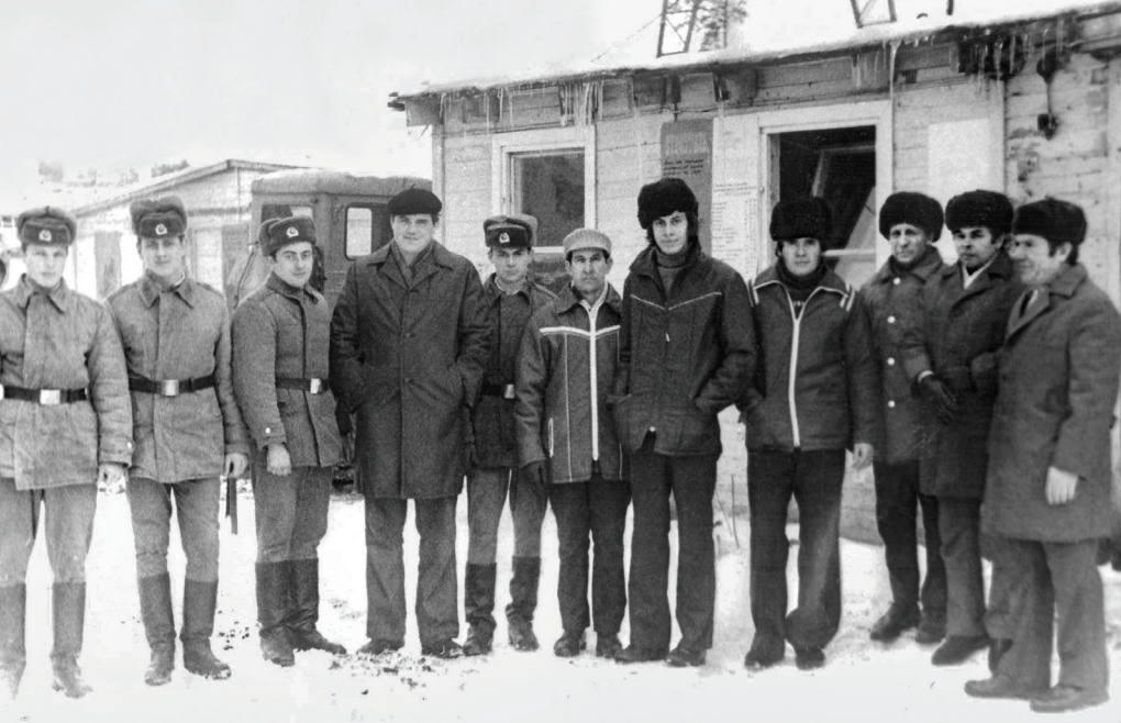
Бригада каменщиков участка № 1 СМУ-5 на строящемся объекте — здании 11 Централных экспериментальных мастерских ОИЯИ. 4-й слева прораб С. Е. Ткаченко, 1-й справа В. Ф. Рябцев. 1978 г.
