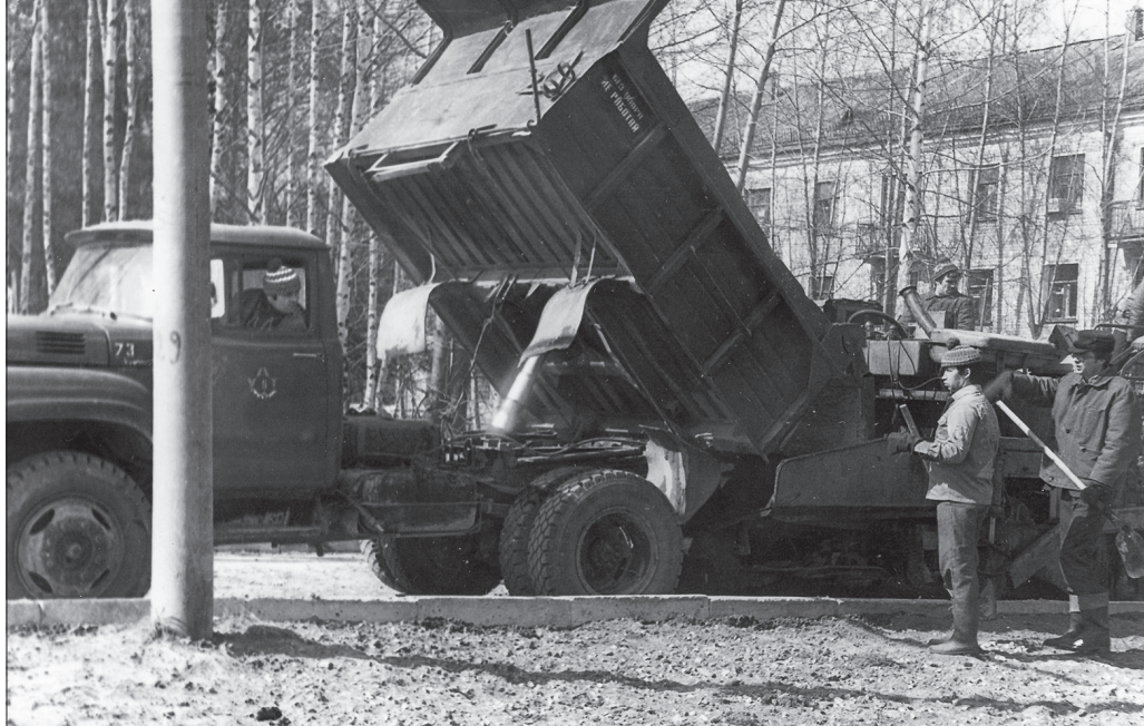
Коммунистический субботник. Укладка асфальта
