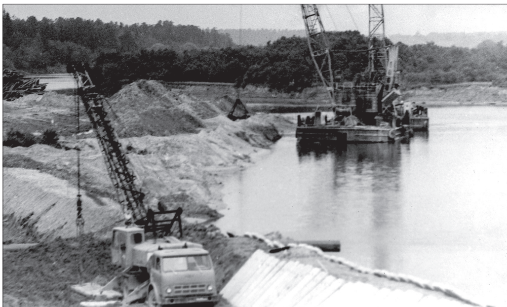
Строительство причала механизированной приемки инертных материалов на р. Дубне
