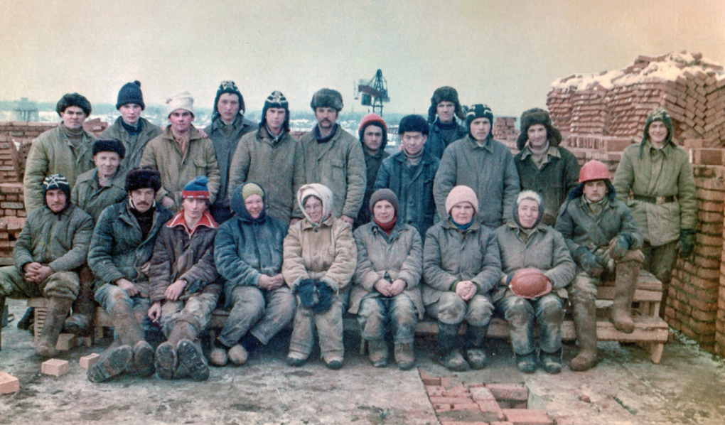
Бригада каменщиков А. С. Зятева. Слева направо, верхний ряд: Балашов А., Костюгов В., Заломанов Н., Уханов В., 2 военных строителя, Зятев А., военный строитель, Ко Зон Бон, Богданов В., военный строитель, Гарифулин Р., военный строитель; нижний ряд: Гуркин А., Андреев А., Шилина Л., Воробьева Т., Шавырина А., Богданова Л., Гарифулина М., военный строитель
