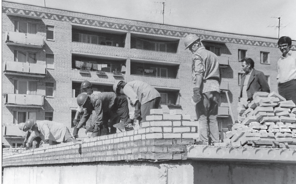
Строительство жилого дома в Запрудне. Справа А. В. Беклемищев и Л. Д. Пахтеев. 1982 г.
