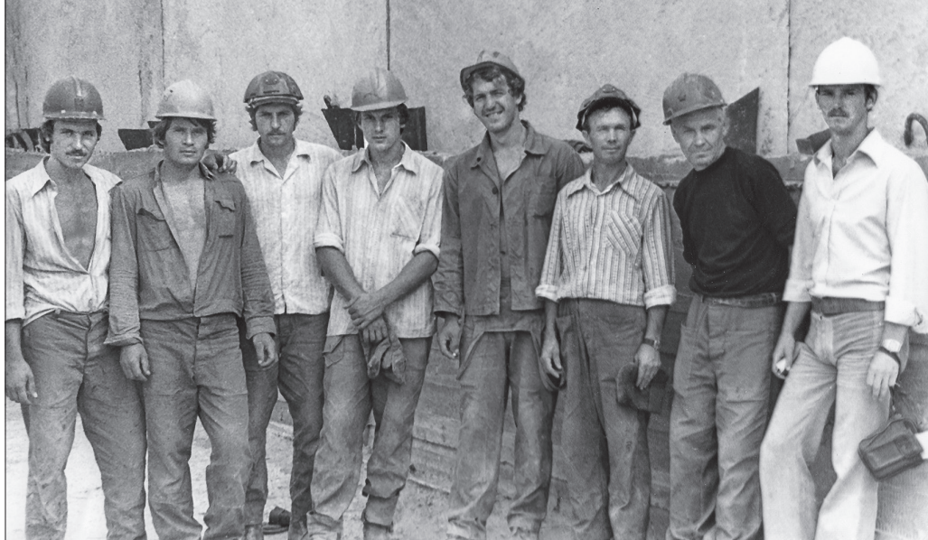
Бригада строителей на объекте «Комплекс очистных сооружений». Справа прораб С. А. Карякин
