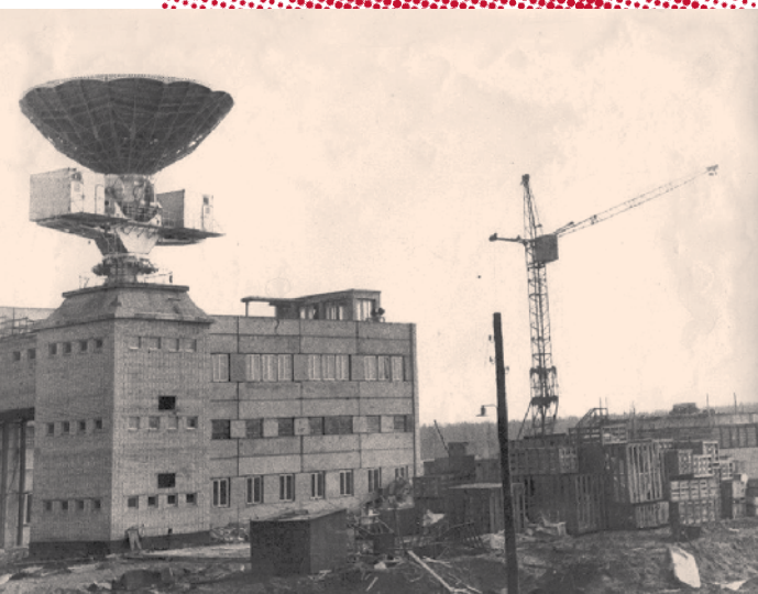
В разгар строительства 1978 г.
