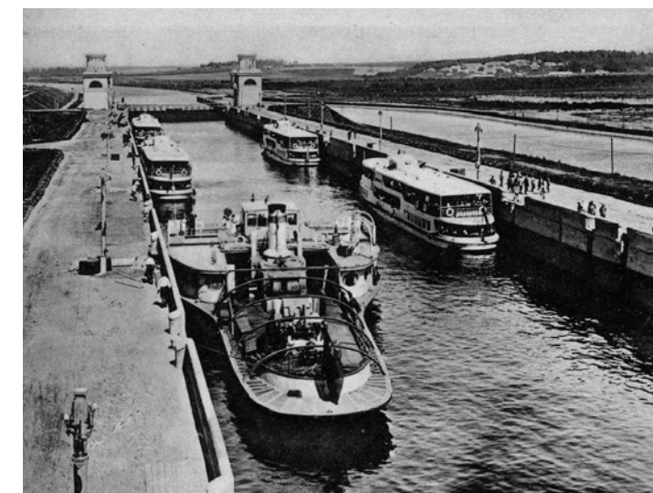
Шлюз № 5 на канале Фотография Н.С. Грановского
