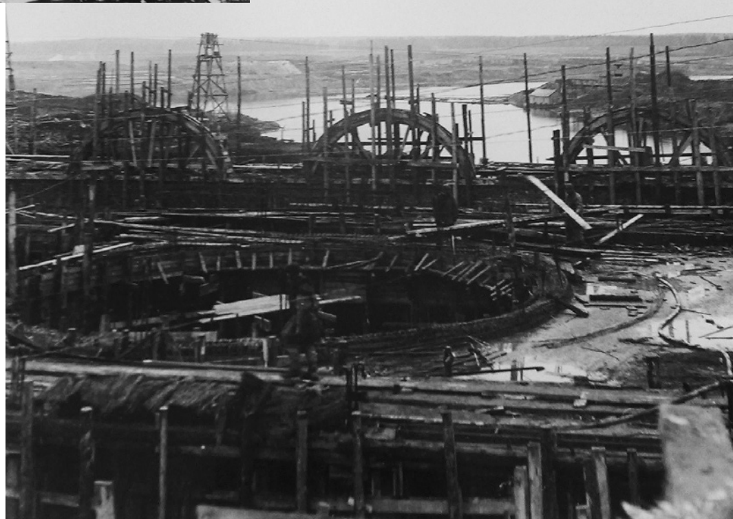
Строительство Ивановской ГЭС
