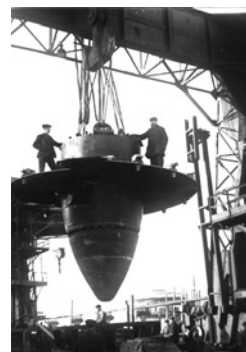
Монтаж турбины ГЭС
