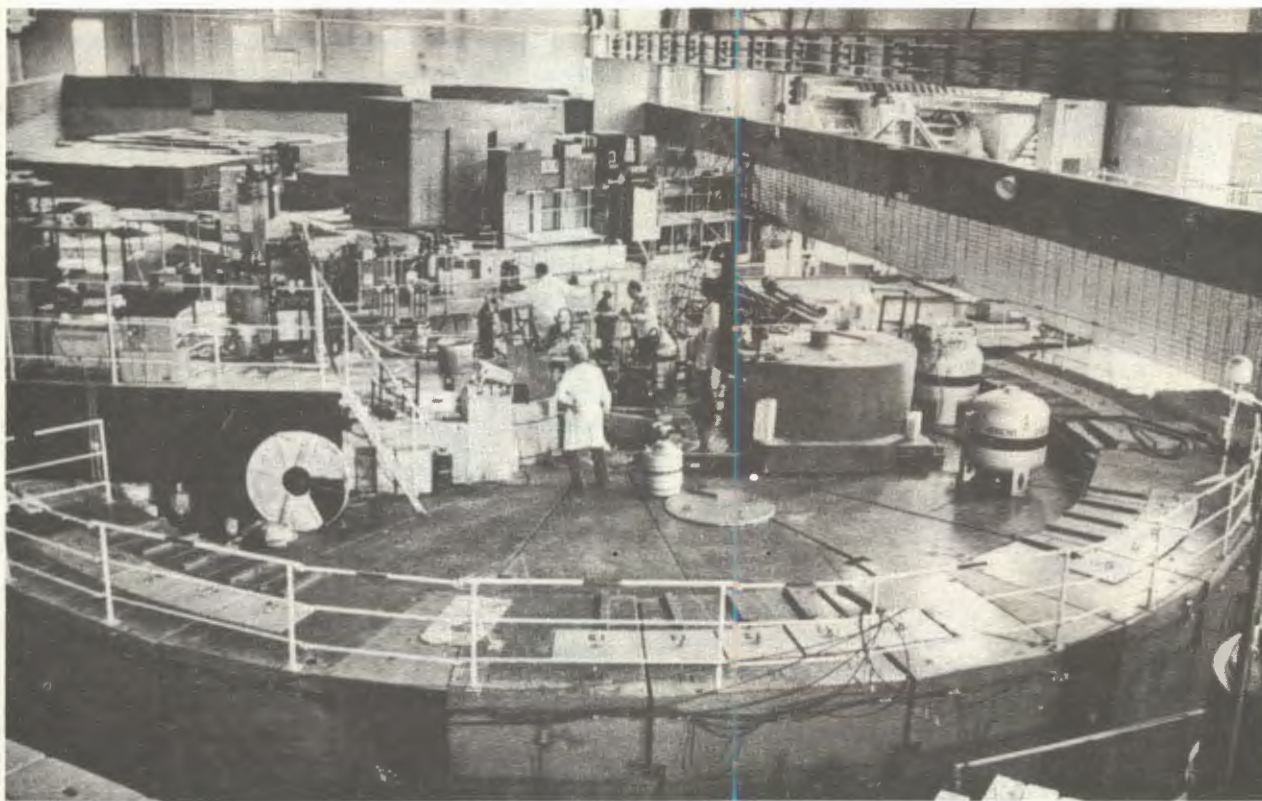
Экспериментальный зал реактора ИБР-2. На переднем плане: спектрометр ДИН-2 для исследований атомной структуры и динамики кристаллических и аморфных тел
