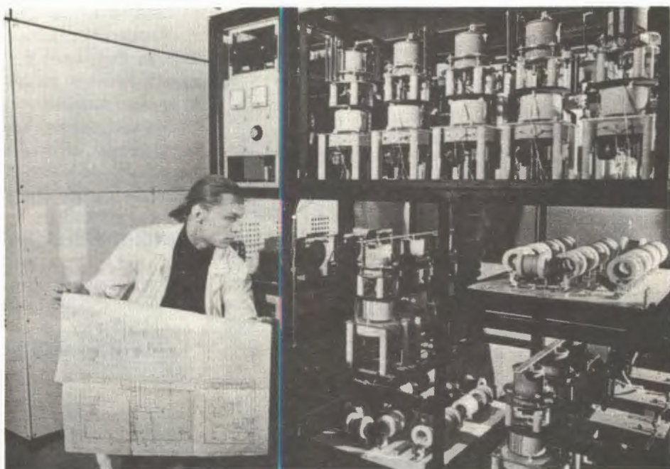
Система подавления поперечных колебаний пучка частиц для ускорительного комплекса ИФВЭ (Протвино)
