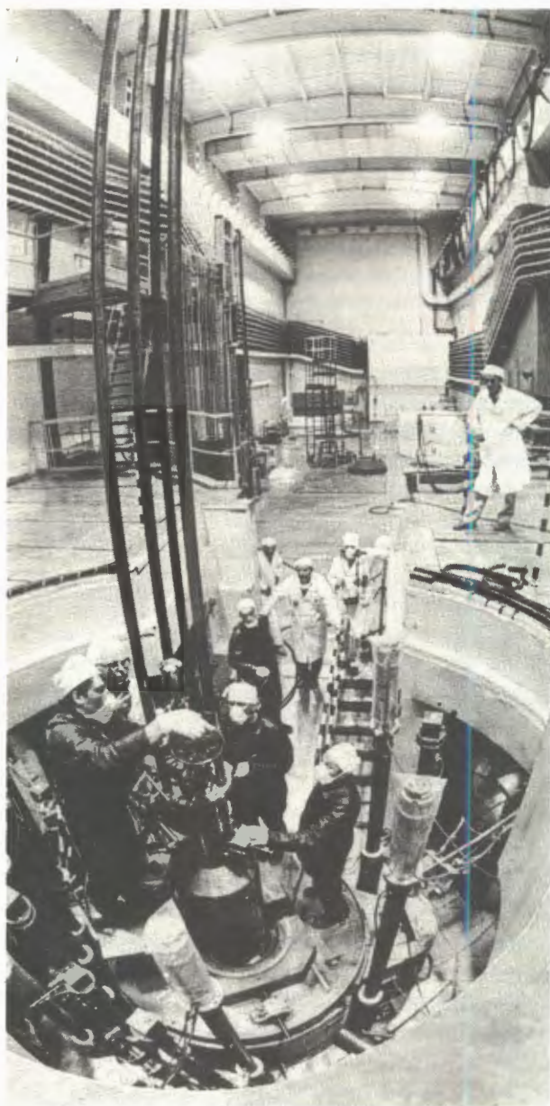
Регламентные работы по догрузке активной зоны реактора ИБР-2
