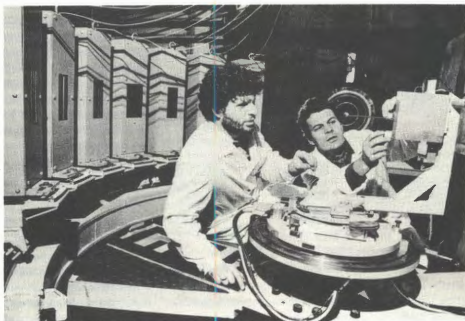
Текстурный нейтронный дифрактометр НСВР
