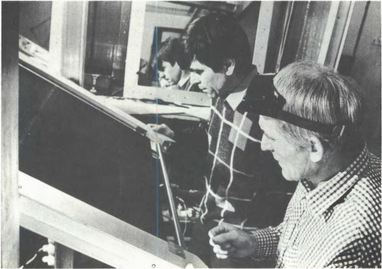
По проекту ФРЕД в ЛЯП создаются быстродействующие пропорциональные камеры. На снимке: момент сборки узкозазорной ПК
