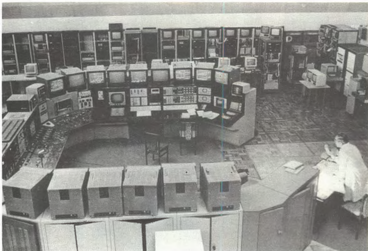
Зал управления ускорительным комплексом синхрофазотрона. На заднем плане – консоли управления и контроля системами нуклотрона в стадии монтажа и наладки
