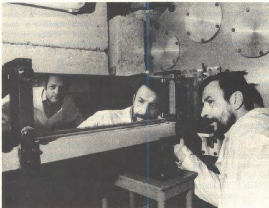
На стометровой пролетной базе канала ИБР-2 ведется монтаж текстурного дифрактометра НСВР. На снимке: юстировка секции зеркального нейтронотода
