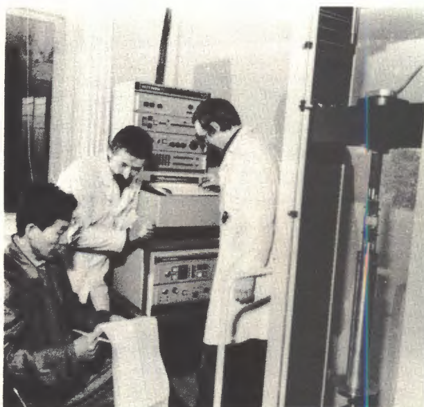
Установка для изучения изменений механических свойств различных материалов при ионном облучении.
