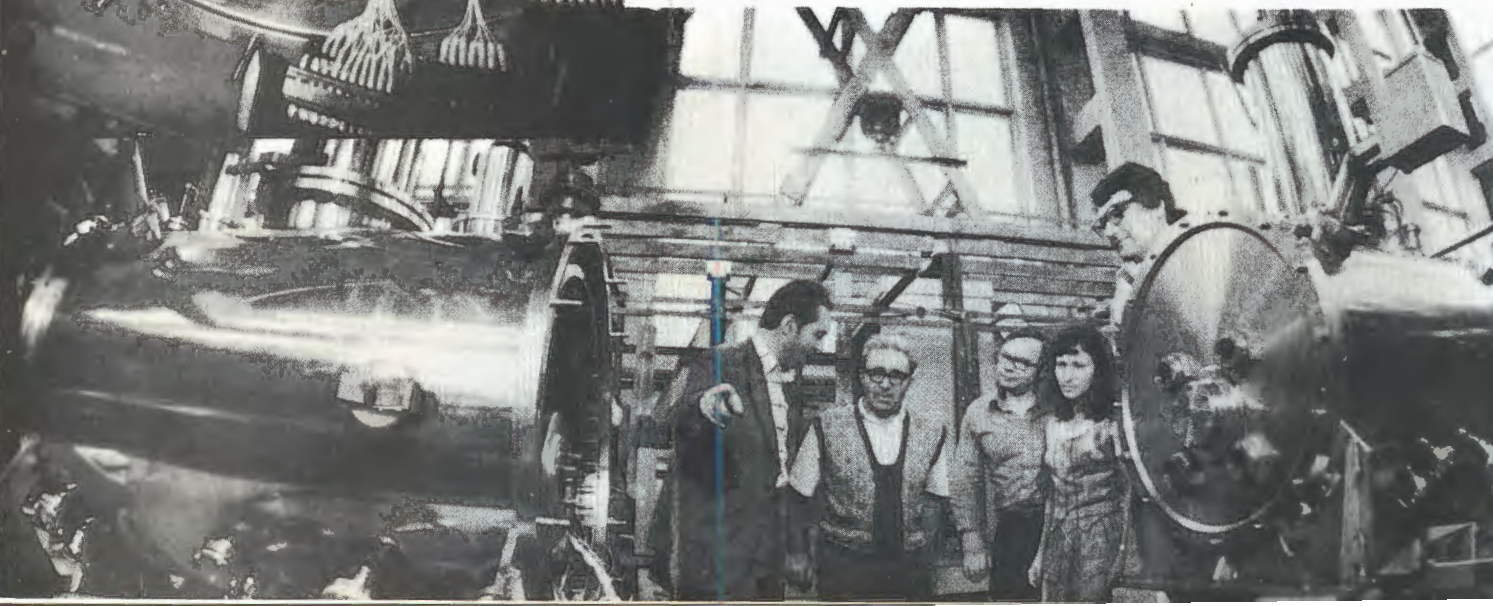
В соответствии с программой работ по проектам нуклофона и УНК проводятся исследования сверхпроводящих материалов и магнитов. С участием специалистов из ЧССР исследованы характеристики сверхпроводящего диполя.
