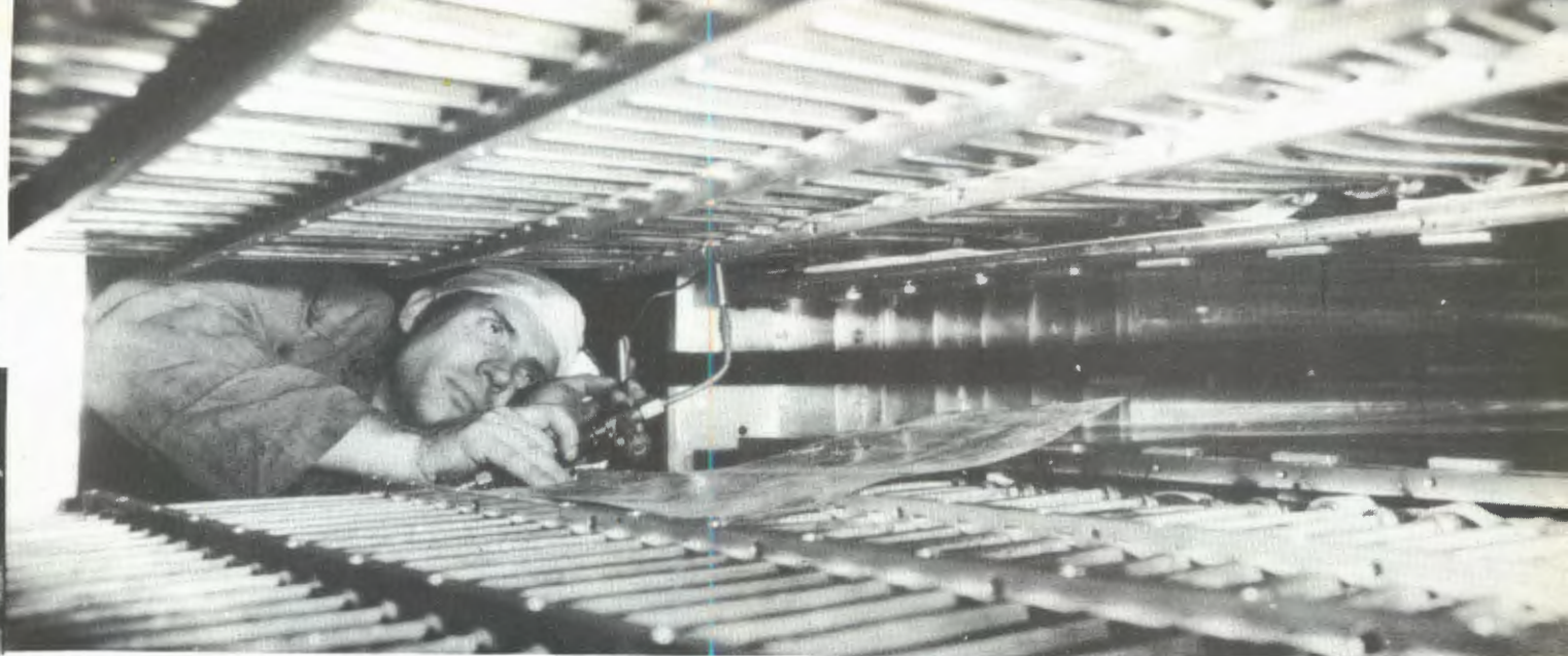
Монтаж катушек в зазоре между полюсами циклотрона.
