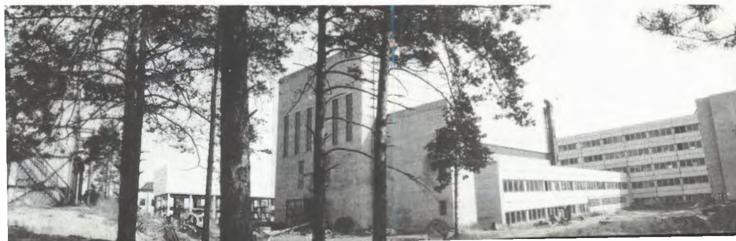
Ускоритель У-400 монтируется в новом здании ЛЯР, начаты работы по отделке здания.
