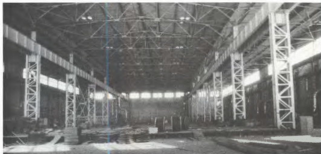
Здание 205 ЛВЭ подготовлено к монтажу каналов выведенных пучков релятивистских ядер.
