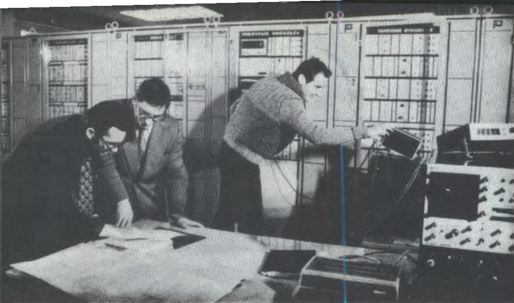
Важнейшая часть управления реактором - электронная аппаратура, разработанная польскими специалистами из Сверка. Во время пуска система управления выдержала экзамен.
