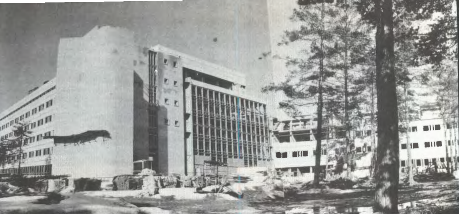
Заканчиваются общестроительные работы по корпусу 134 ЛВТА.
