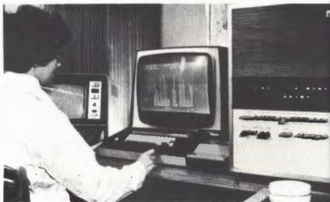
Проверка работы одной из систем контроля СКМ-200 на линии с ЭВМ ТРА-1000i.
