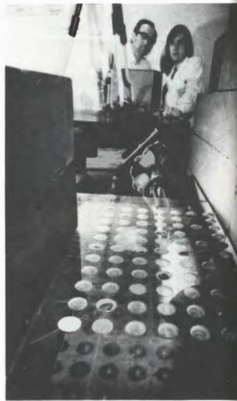
Продолжались эксперименты по поиску долгоживущих сверхтяжелых элементов в природе с использованием нейтронного детектора, установленного в соляной шахте.
