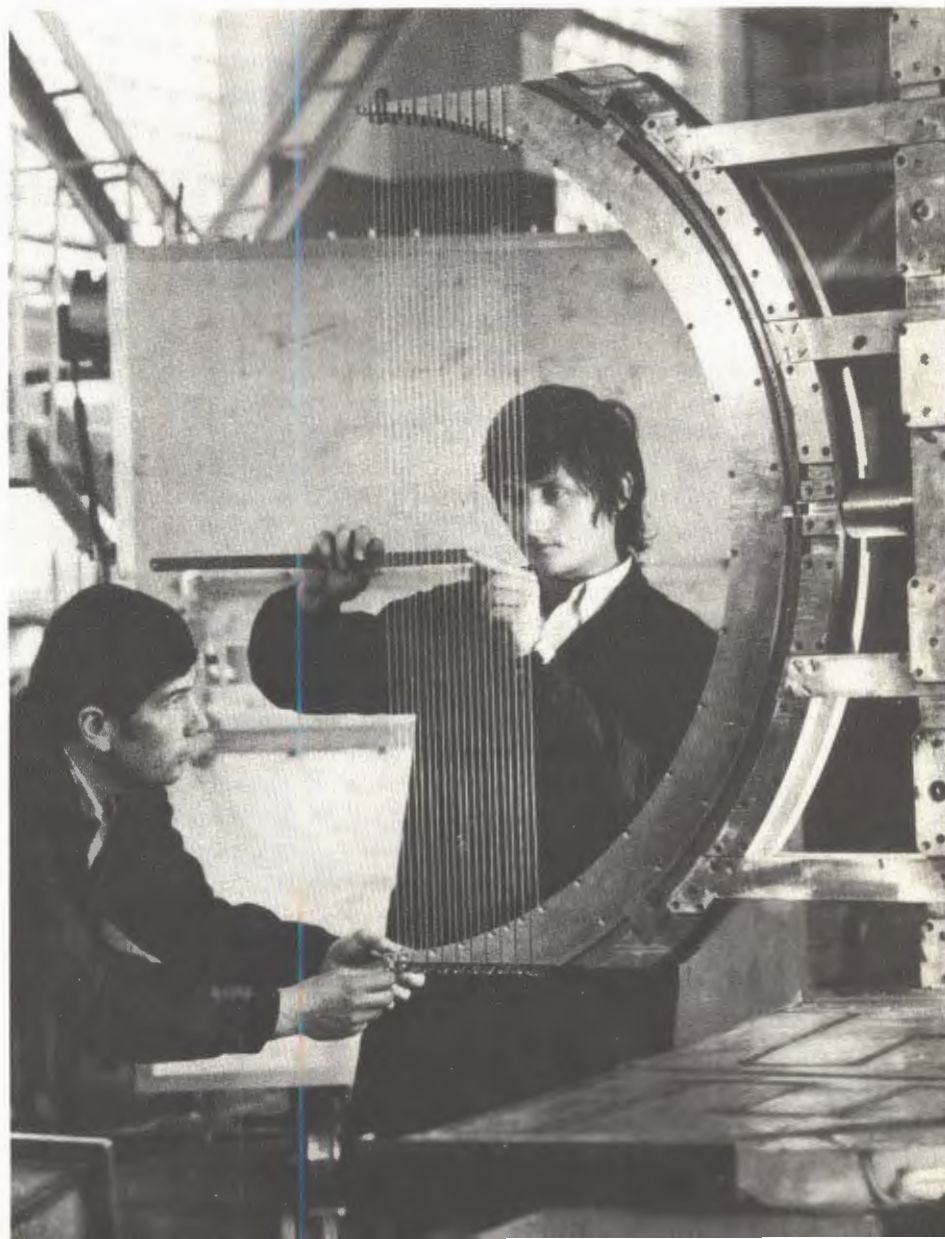
Регулировка натяжения струн на основе дуанта.
