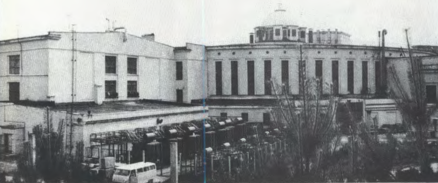
Строительство нового экспериментального зала /площадью 10 тыс. кв. метров/ в Лаборатории высоких энергий.
