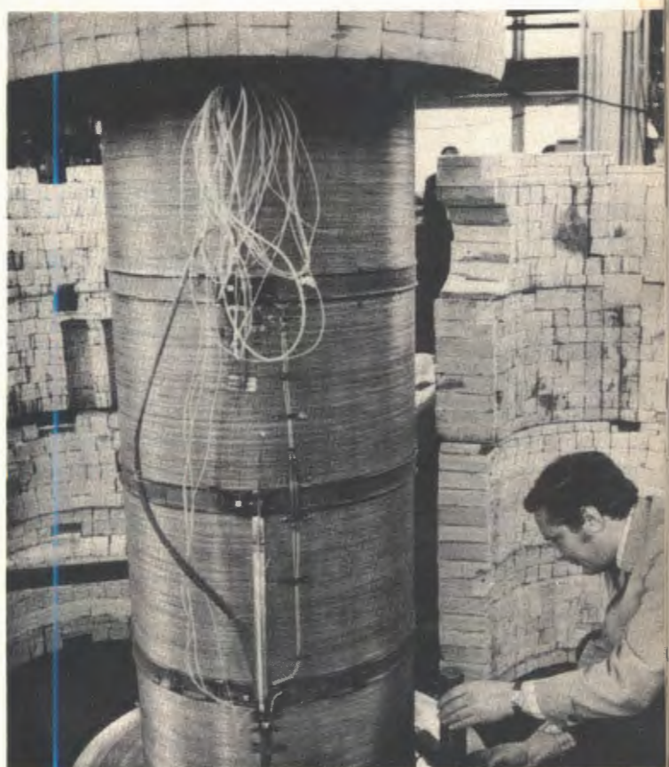
Главный соленоид кольцетрона для исследований по проекту ускорителя протонов высоких энергий.
