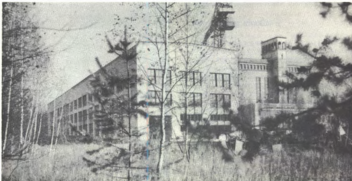
48. Строительство специального корпуса для монтажных работ, связанных с созданием сильноточного фазотрона (реконструкцией синхроциклотрона).
