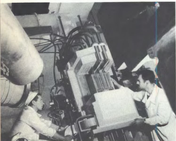
Рис. 99. Начата эксплуатация нового реактора ИБР-30. Объем активной зоны реактора 2,5 л, средняя тепловая мощность 30 квт, длительность вспышек нейтронов 50 мксек (при частоте повторения импульсов 51/сек), мгновенная мощность в импульсе 150 Мвт.
