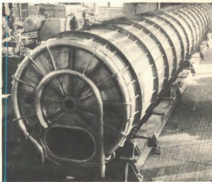
Рис. 70. Поворотный магнит для канала транспортировки выведенного пучка протонов из синхрофазотрона.
