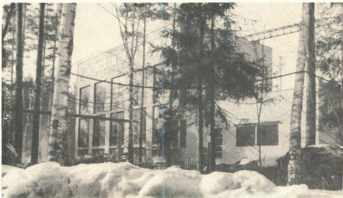
Рис. 88. Строительство нового корпуса для испытания пузырьковых камер и других криогенных работ.
