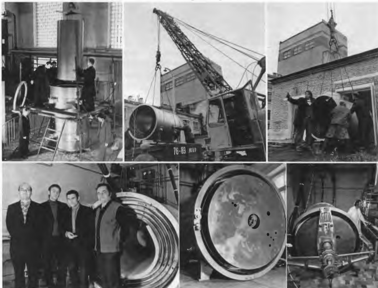
Рис. 99. Верхний ряд, слева направо: сборка экрана в экспериментальном зале ИБР-30; перевозка экрана в здание 77. Нижний ряд: конструктора В.И.Константинов, Н.А.Алексеев, Б.И.Воронов и Ю.В.Таран; человек в “магнитном вакууме”; экран в собранном виде.
