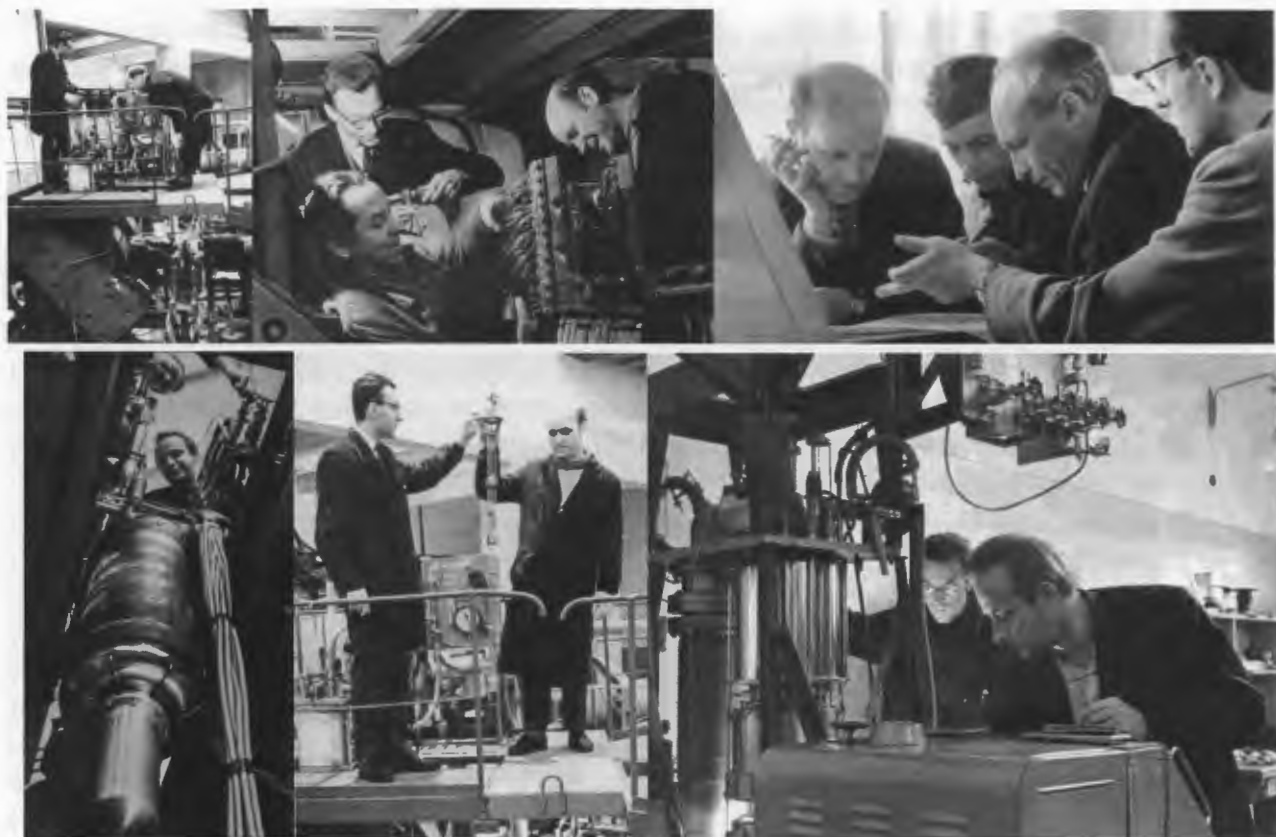
Рис. 29. Эксперименты с поляризованной гольмиевой мишенью на канале № 3 реактора ИБР и бустера ИБР + микротрон с использованием ППМ-2 и ППМ-3 (1964 – 1965 г.г.).
