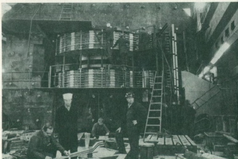
Монтаж изохронного циклотрона У-400.
