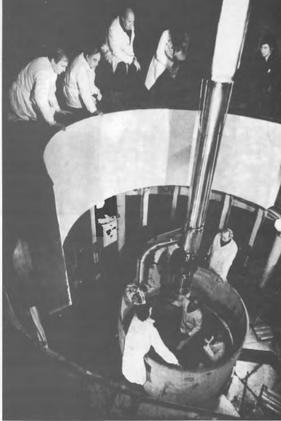
Монтаж активной зоны реактора ИБР-2
