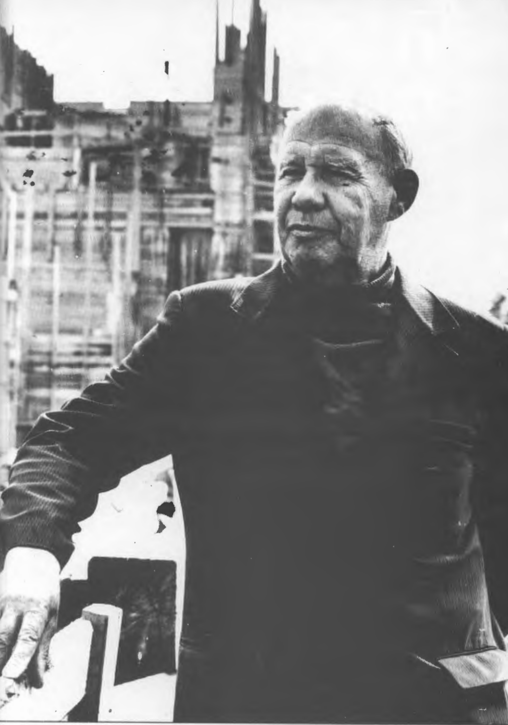
Д.И.Блохинцев на фоне строящегося реактора ИБР-2. Дубна, 1972 г.
