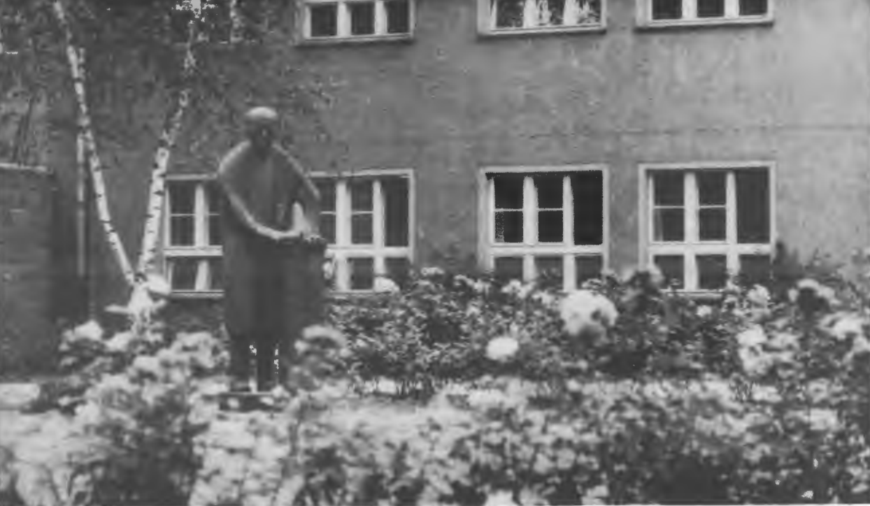
Центральное здание Института физики высоких энергий АН ГДР в Цойтене. На переднем плане - памятник Макс Планку.
