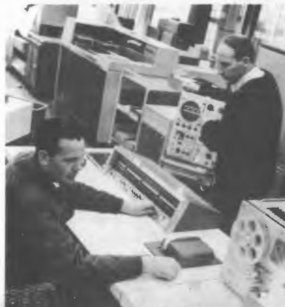
Для эффективного использования малой ЭВМ СДС-160А в системе обработки камерных снимков сотрудники Института применили фотосчитающее устройство, позволяющее быстро вводить данные в машину.
