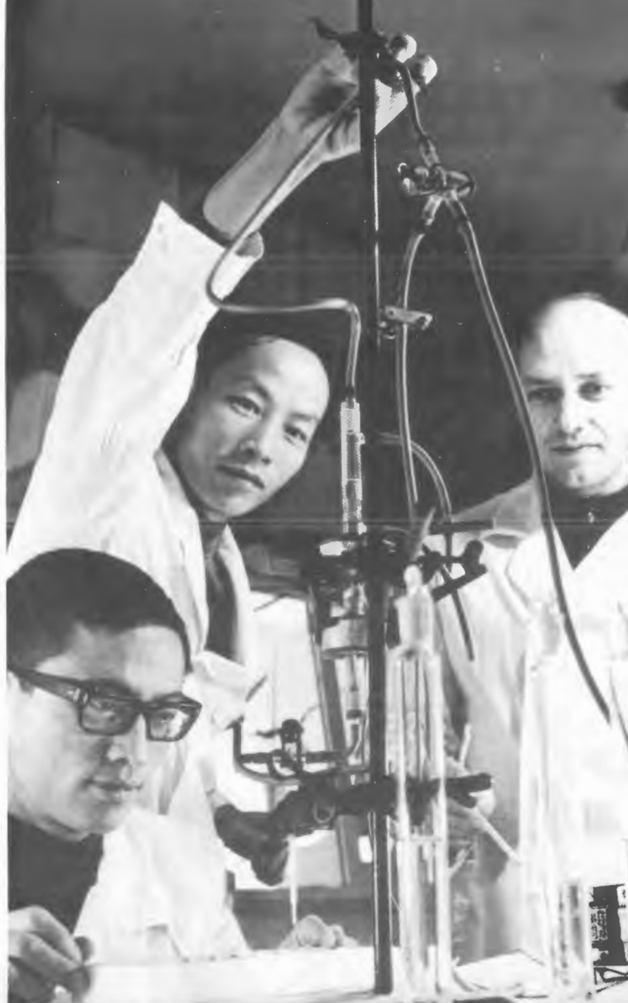
Радиохимические работы занимают важное место в исследованиях ядерных реакций, происходящих под действием тяжелых ионов. Научные сотрудники Ю.С.Короткин и К.А.Гаврилов проводят радиохимическое разделение облученной мишени.
