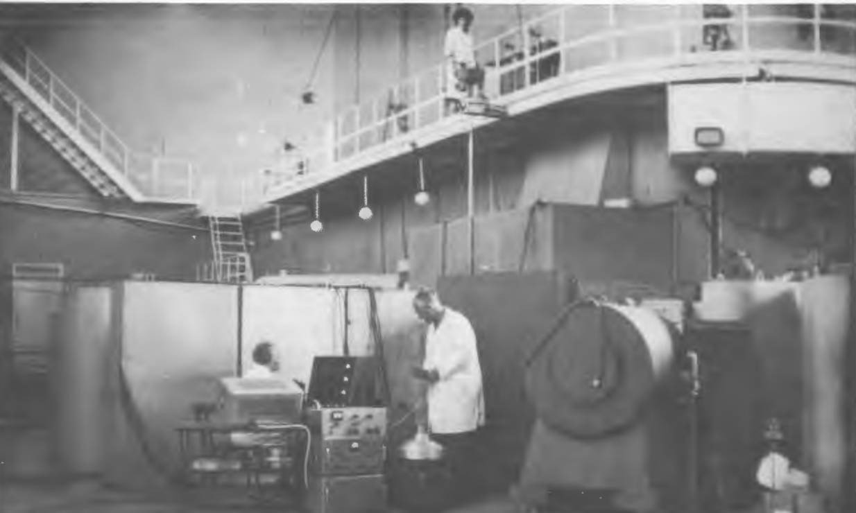
Наладка аппаратуры для исследования диф- фузии и термализации нейтронов на третьем горизонтальном кана- ле реактора ИРТ- 2000.
