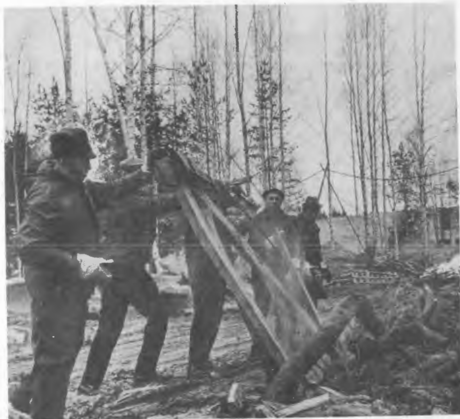
Субботник на строительстве ИБР-2.
