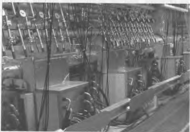
Дефлекторы и мощные усилители СП в тоннеле LHC
