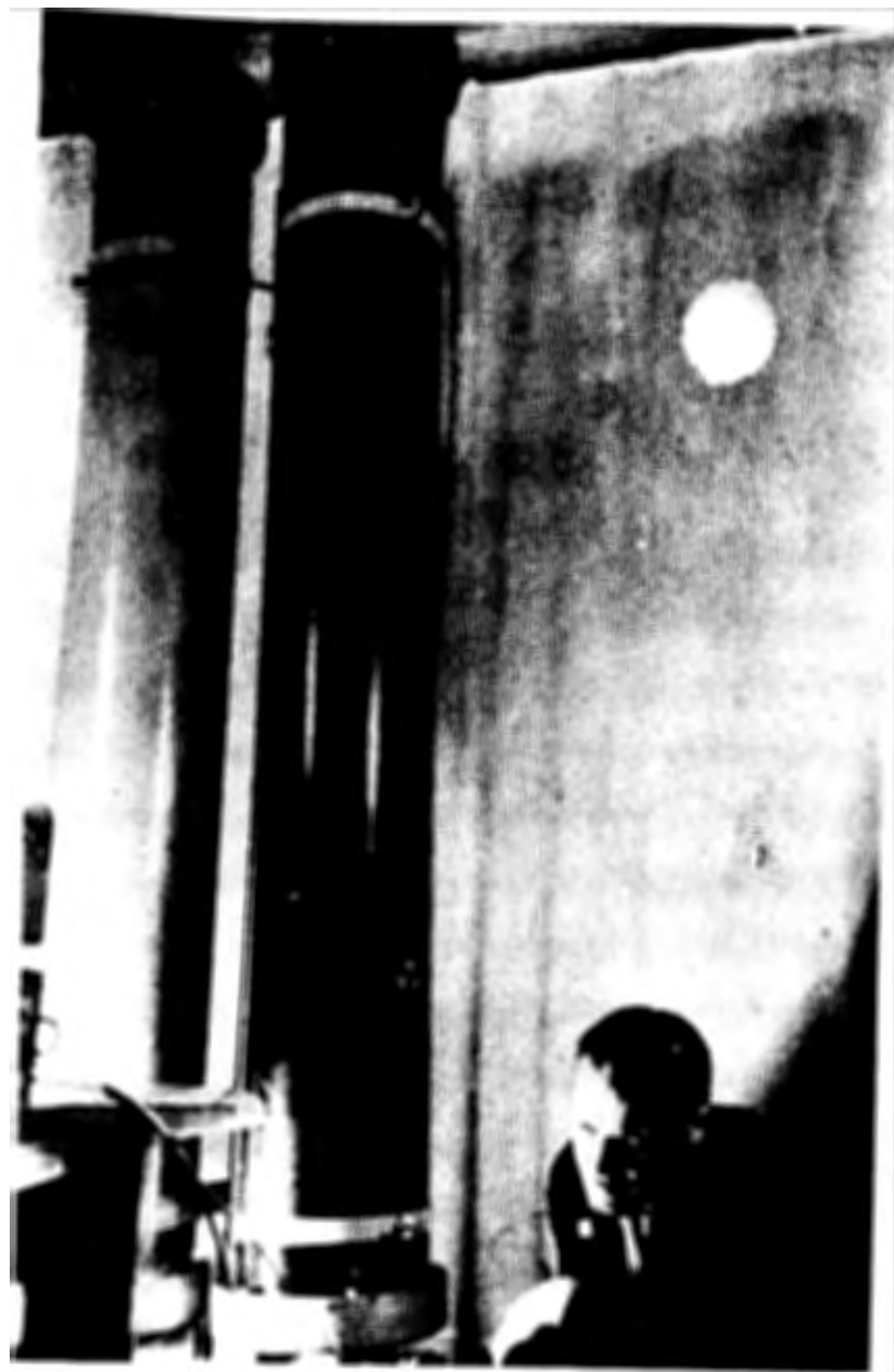
Рис.3. Большие пропорциональные счетчики, применявшиеся для регистрации осколков спонтанного деления /44/.
