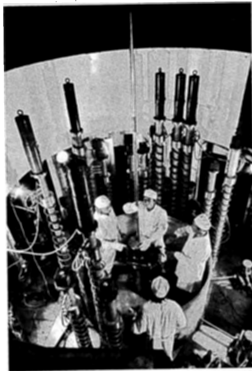
Рис. 3. Сборка активной зоны реактора ИБР-2.
