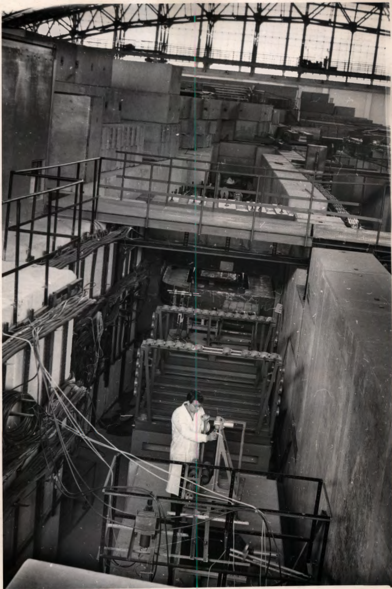
Рис 2. Вид канала в момент монтажа оборудования на нем.
